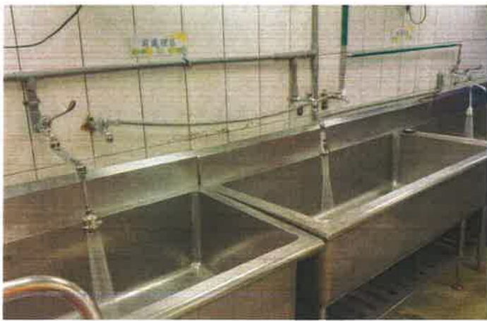
雙永國小廚房已完成加裝沖壓式水柱
